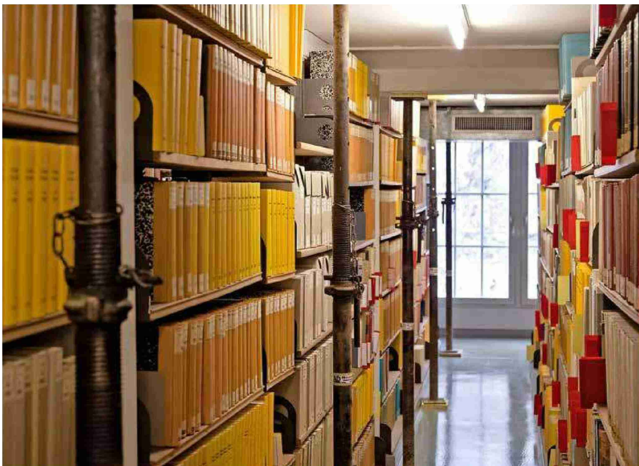
250 Stahlstützen wurden angebracht, um Statikprobleme notdürftig zu beheben.
